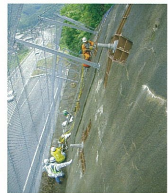
SAAMジャッキを用いた調査状況
