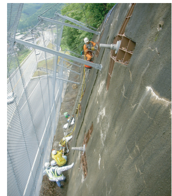
SAAMジャッキを用いた調査状況
