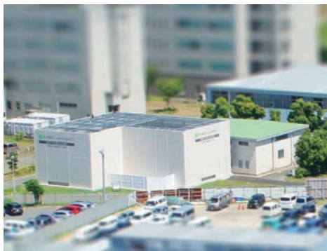
ガスコージェネレーション設備
